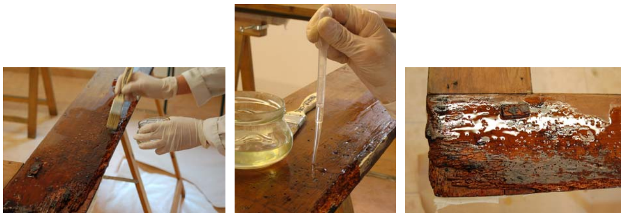
Aplicació de la resina amb paletina i xeringa. Penetració del producte.
