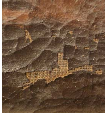
Zona amb pèrdua de tots els estrats i amb perill de despreniment dels aixecaments de la capa de preparació
