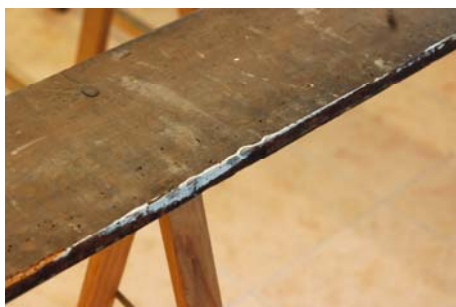
Taques de pintura plàstica al suport.
