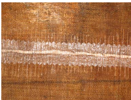
Detall del reforç estructural de la zona d'unió de les dues teles del suport
